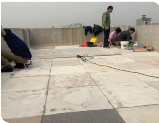
Vệ sinh xịt rửa bề mặt
