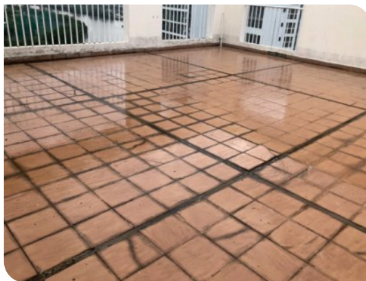
Thi công lớp lót
