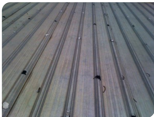
Vệ sinh xịt rửa bề mặt
