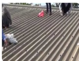
Bơm keo các mép tôn và lỗ vít
