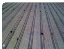
Bề mặt đã được tẩy gỉ sét
