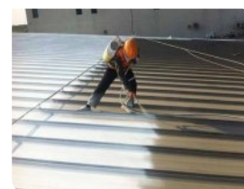
Bề mặt tôn đạt yêu cầu
